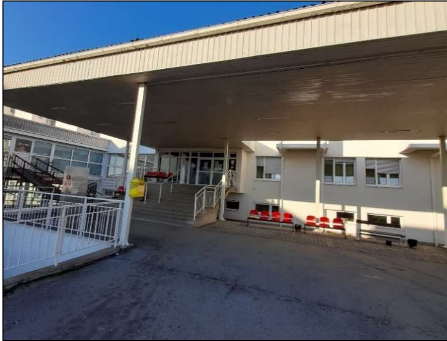
Slika 3 – Ulaz u zgradu OŽB Požega
