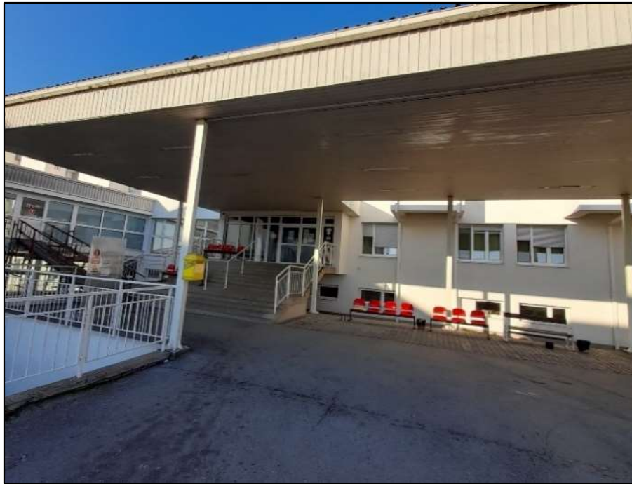
Slika 3 – Ulaz u zgradu OŽB Požega
